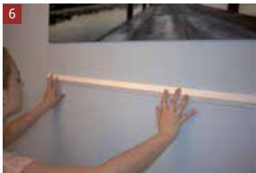
Sorgen Sie für einen sauberen, trockenen, glatten und tragfähigen Untergrund. Legen Sie die Leiste genau in den Wand-Deckenwinkel ein und drücken Sie sie sorgfältig über die ganze Länge an. Entfernen Sie heraustretenden Kleber sofort mit einem feuchten Lappen.
