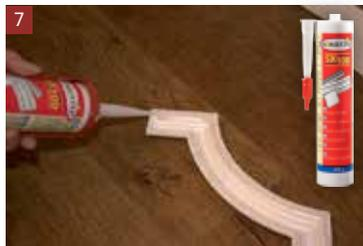
Bei der Verwendung der HOMESTAR Bögen und Schmuckelemente tragen Sie den Kleber durchgängig auf die Auflagefläche auf. **Verwenden Sie unseren Kleber HOMESTAR SX 100 bzw. lösemittelfreie Kleber.** Beachten Sie dabei die Angaben des Herstellers.
