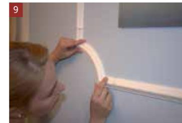
Tritt nach dem Anbringen Kleber an den Übergängen heraus, nutzen Sie diesen gleich und verspachteln die Übergänge. Nach 4 Stunden Trocknungszeit schleifen Sie den Kleber an den Übergängen leicht ab.
