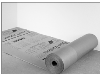
Unterboden auf vorbereitetem Untergrund auslegen.
