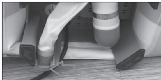
3. Enrosque el cartucho de filtro girándolo en el sentido de las agujas del reloj sobre la entrada de agua de la pared del SPA y coloque la cubierta sobre el cartucho de filtro. Esta cubierta retiene el cabello y las partículas de suciedad gruesas, que de lo contrario contaminarían más rápido su cartucho de filtro.
