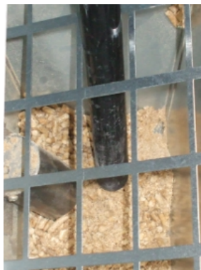
Fig. 60 - Reinigung Tank und Schnecke
