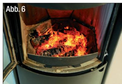
Lassen Sie diese Holzscheite mit auf "AUF" stehender Primär- und Sekundärluft herunterbrennen, bis kaum noch Flammen vorhanden sind und das Holz in die Glutphase übergeht (Abb. 6). Je nach Holzgüte, Schornsteinzug und Witterung dauert diese Verbrennungsphase unterschiedlich lange.
