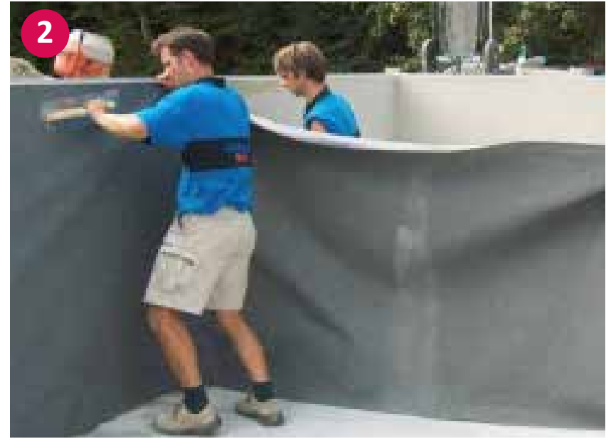
▲ Punktuelle Befestigung der Vliestrennlage mittels Styroporkleber
