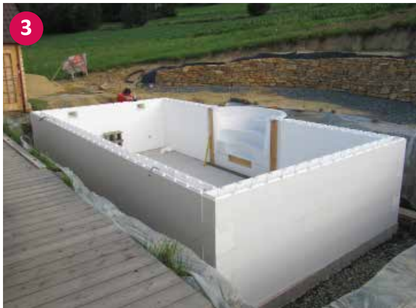
▲ Aufgestelltes Styroporstein Becken mit Römertreppe – ohne Betonfüllung
