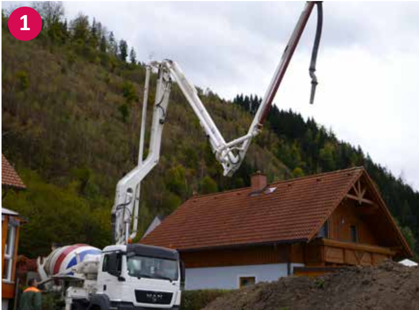
▲ Betonwagen mit Betonpumpe und Fallbremse
