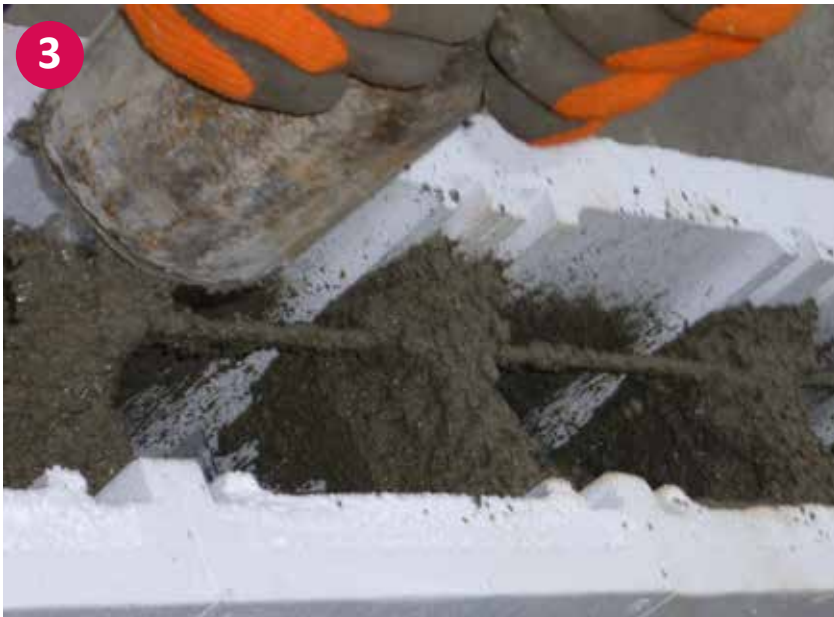
▲ Detailsicht: Ausfüllen der Styroporstein mit dem Beton
