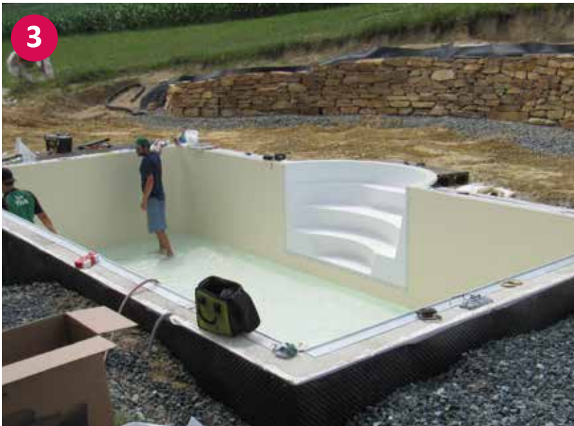
▲ Einhängen des Foliensacks und Anflanschen der Einbauteile
