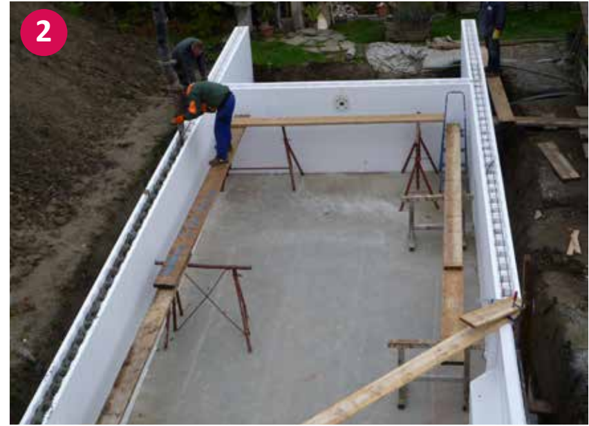
▲ Ausfüllen der Styroporstein mit dem Beton
