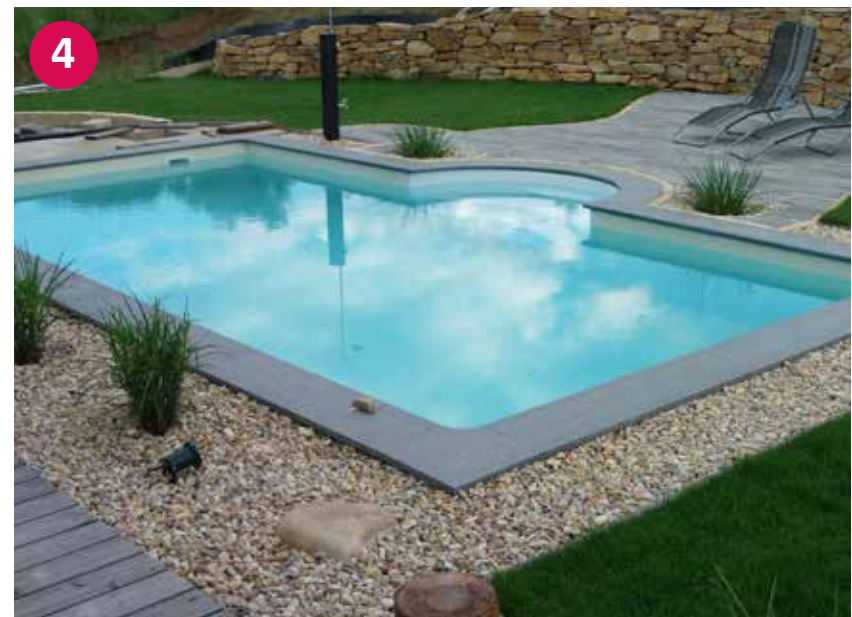
▲ Fertiges Styroporsteinbecken mit Römertreppe
