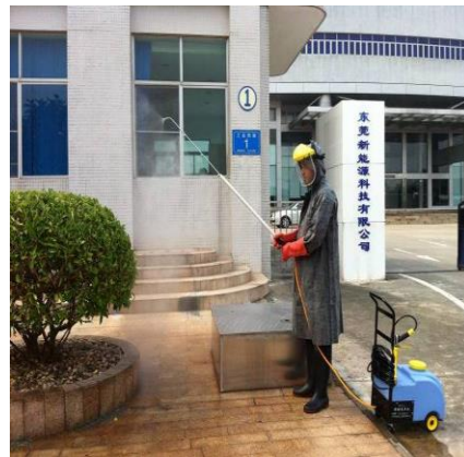
图片 2 水雾灭火器 (穿着 PPE 防止触电)
