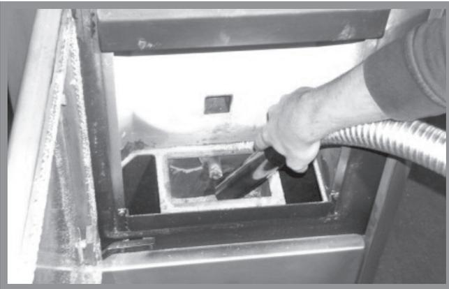
Abb. 12f: Reinigung Brennraumbehälter
