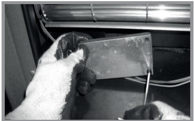
3. Überprüfen Sie, ob sich Asche hinter der Abdeckplatte befindet und saugen Sie diese sorgfältig aus (siehe Abb. 13c). Saugen Sie die Asche so auf, dass kein Aschewirbel im Aschekasten entsteht. Nur wenn in regelmäßigen Abständen (2-3 Monate) die Öffnung hinter der Abdeckplatte ausgesaugt wird, kann für einen einwandfreien Betrieb garantiert werden
