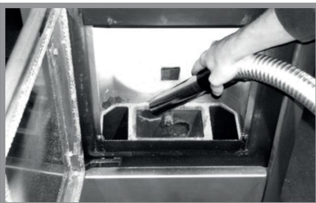
Abb. 12d: Reinigung der Topfhalterung
