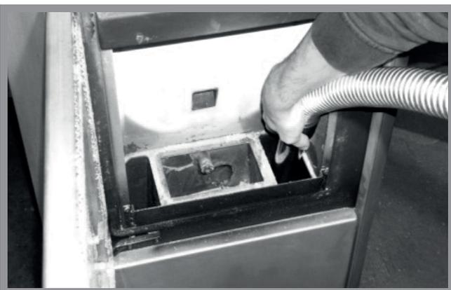
Abb. 12g: Reinigung untere Brennkammer
