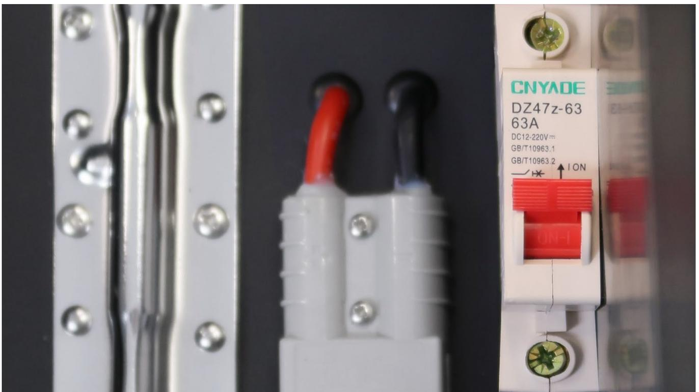
Die Hauptsicherung ist eingeschaltet: Der Schalter befindet sich oben in der ON-Stellung und signalisiert: Aufpassen - Strom fließt!
