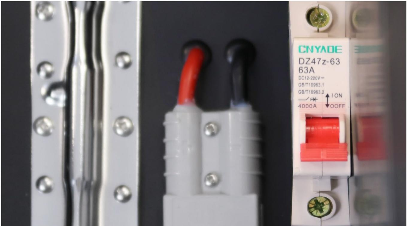
Die Hauptsicherung ist ausgeschaltet: Der Schalter befindet sich unten in der OFF-Stellung und signalisiert: Es ist sicher - kein fließender Strom.
