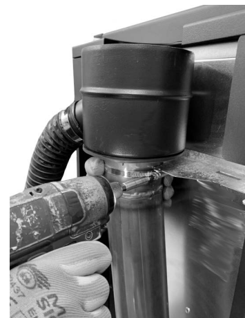
Fig. 48 - Mit Schelle sichern
