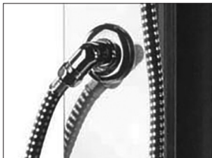
монтаж на шланга на душа към арматурата
