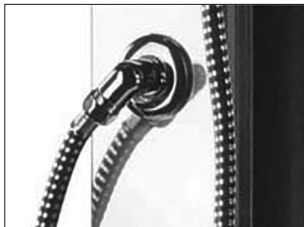
Montaža crijeva tuša na izlaz armature
