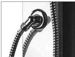
Montaža cevi prhe na odvod pršne armature
