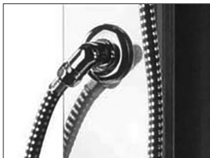
подсоединение душевого шланга к выводу душевой арматуры
