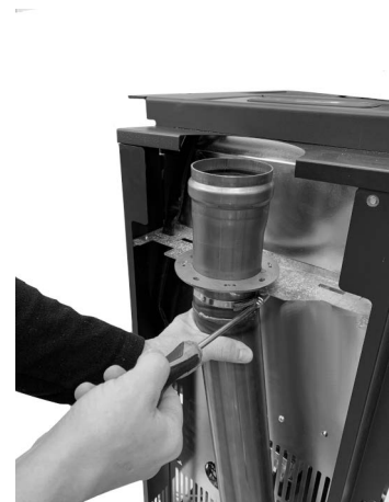
Fig. 42 - Mit Schelle sichern
