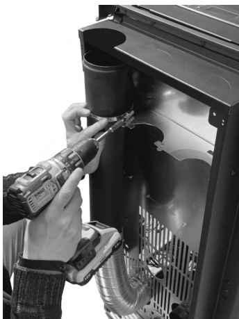
Fig. 63 - Rohr D. 80 mm sichern
