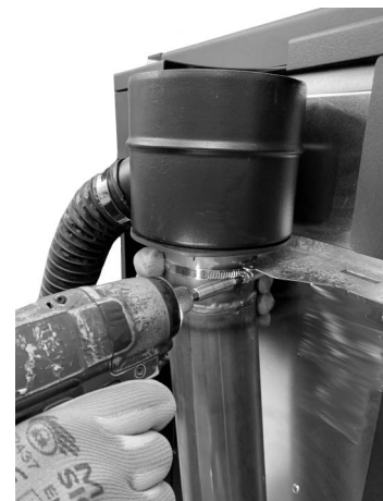
Fig. 48 - Mit Schelle sichern
