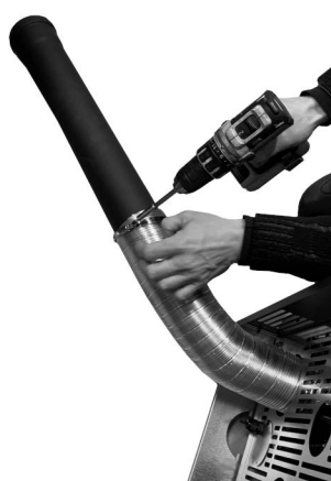
Fig. 61 - Rohr D. 80 mm anschließen
