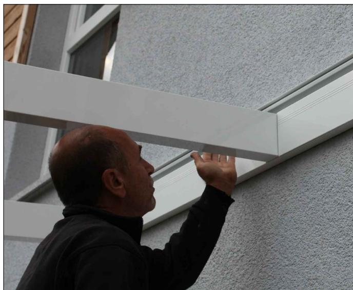
Verteilen Sie die anderen Sparren mit Hilfe der Blendleisten (dienen als Abstandshalter), bohren Sie die Schraublöcher mit einem 4mm Metallbohrer vor und verschrauben Sie die Sparren mit jeweils einer Karoserieschraube (C101-025) an den beiden Pfetten.
