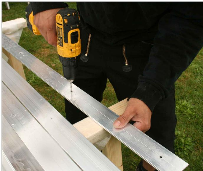
Dichtgummi in die Aluprofile einziehen und die Aluprofile mit einem 5mm Metallbohrer in einem gleichmäßigen Abstand vorbohren. Teilen Sie die Anzahl der Schrauben (siehe Positionsplan) durch die der Sparren um die Gesamtzahl der zu verteilenden Schrauben pro Aluprofil zu erhalten.
