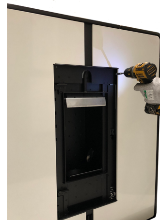
Fig. 40 - Befestigen der Verkleidung
