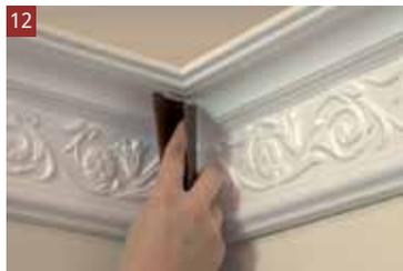
Nach 4 Stunden schleifen Sie den Kleber leicht ab.
