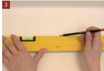
Nutzen Sie gegebenenfalls eine Wasserwaage um sich eine durchgängige Linie als Orientierung zu ziehen.
