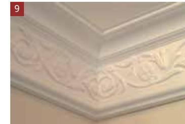
Sorgen Sie für einen sauberen, trockenen, glatten und tragfähigen Untergrund. Beginnen Sie am besten mit der Montage der Innen- und Außenecken. Legen Sie die Leiste genau in den Wand-Deckenwinkel ein und drücken Sie sie sorgfältig über die ganze Länge an. Entfernen Sie heraustretenden Kleber sofort mit einem feuchten Lappen.
