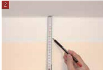
Übertragen Sie die ermittelte Schenkellänge an die Wand. Somit legen Sie den Verlauf der Leistenunterkante genau fest.
