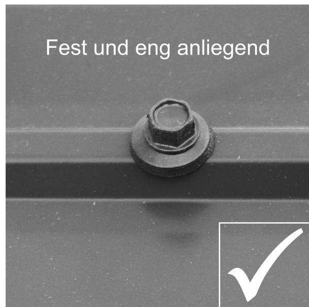
Die Dachschrauben können die Dachplatten und Dachkanten einfach brechen, wenn eine Bohrmaschine benutzt wird. Wir empfehlen, die Dachschrauben handfest anzuziehen, damit sie am Dachmaterial fest sitzen und eng anliegen.
