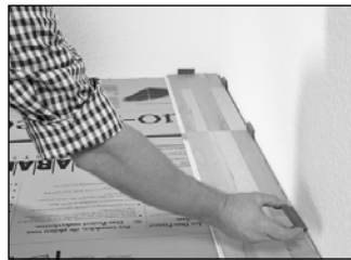
Verlegefläche ausmitteln/auswinkeln und die erste Dielenreihe durch Zuschneiden anpassen.
