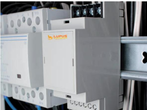
Der smarte Schaltgehilfe für Zuhause: Das XT2 Plus Hutschienenrelais.
