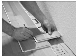
Mit Hilfe eines Reststückes wird der Wandverlauf auf die letzte Dielenreihe übertragen.
