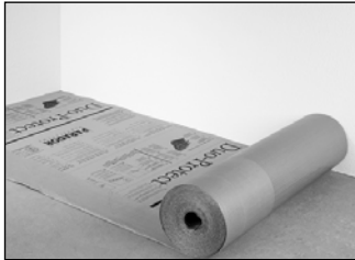
Unterboden auf vorbereitetem Untergrund auslegen.
